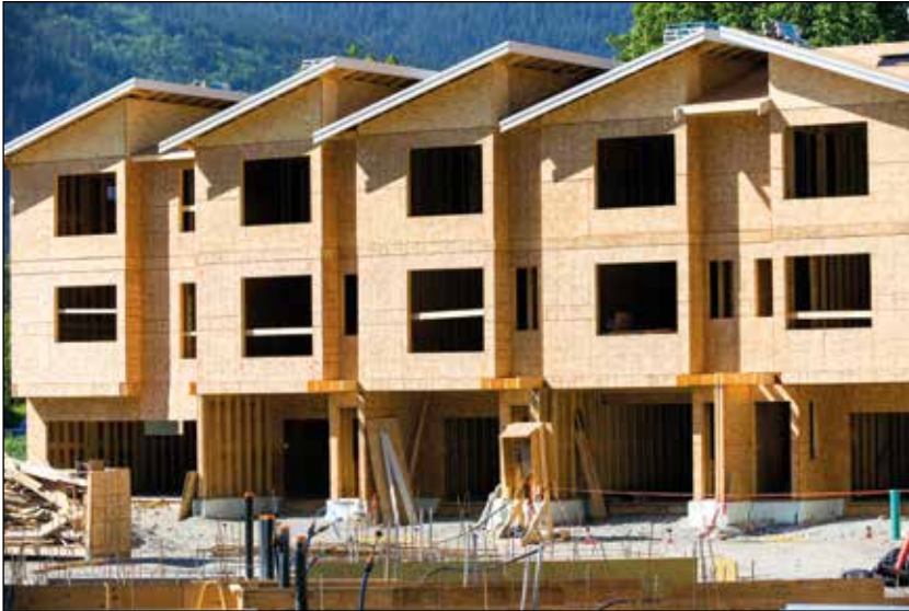
Logement collectif en construction bois.
